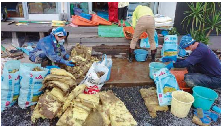
↑断熱材の取出し
