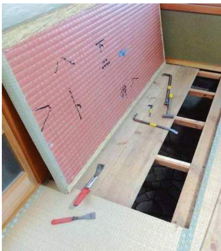
和室の床板をはがす（写真①）
